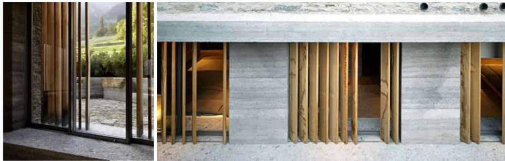
Lamellen aus geölten Lärchenholz. Können geöffnet, geschlossen und gedreht werden. Dienen zur natürlichen Beleuchtung des Innenraums.
