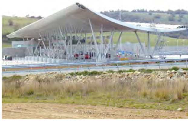
Dach der Maststation Vauduit von Millau aus UHPC, Frankreich, 2004
