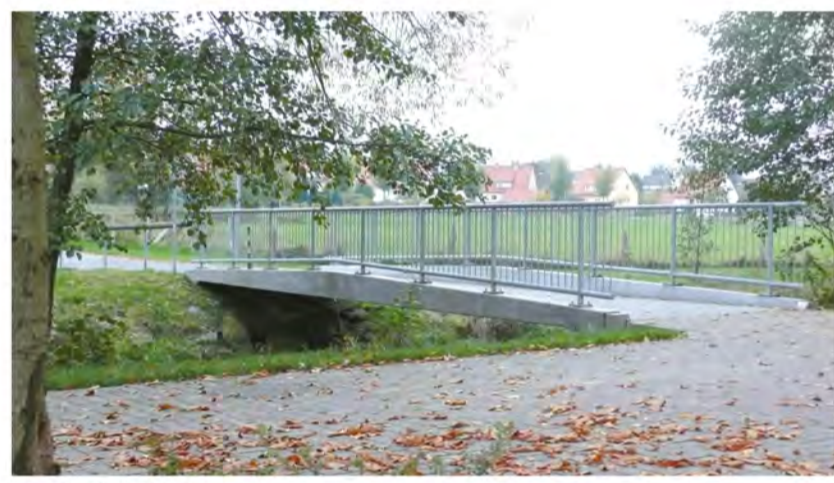
Brücke über den Niesterbach, Kassel
