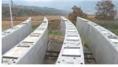
Elemente des Daches der Maststation
