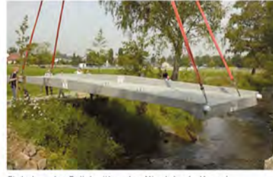
Einbauen der Brücke über den Niesterbach, Kassel
