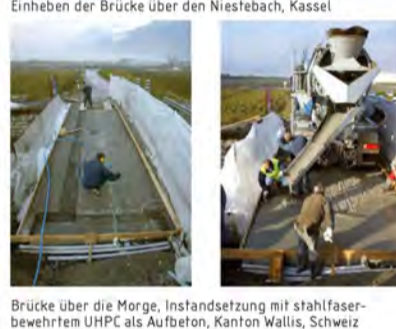
Brücke über die Morge, Instandsetzung mit stahlfaserbewehrtem UHPC als Aufbettung, Kanton Wallis, Schweiz
