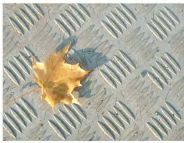
begehbare Brückenelement aus UHPC
